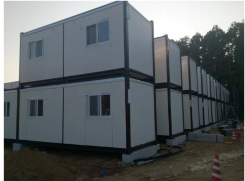
モジュールハウス宿舎棟の設置が急ピッチで進んでいます。
