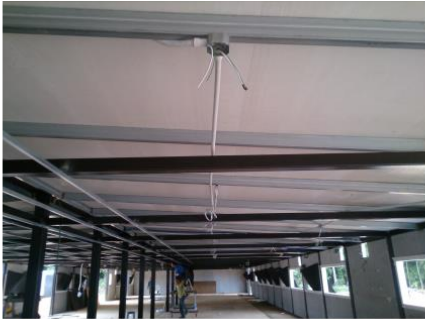
食堂棟の電気工事が始まりました。
