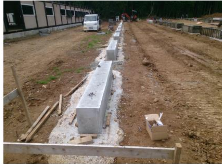
追加200名分の基礎工事が終わりました。
