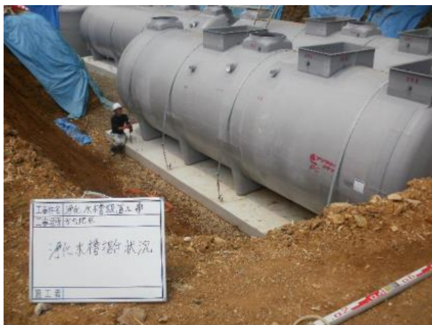
浄化槽埋作業
