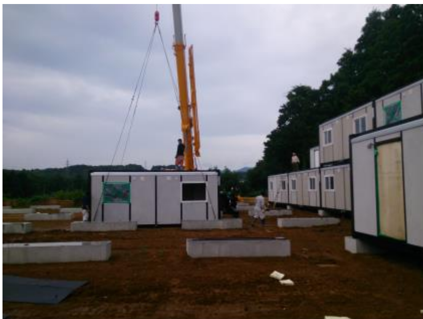
2階部分の設置が始まりました。
