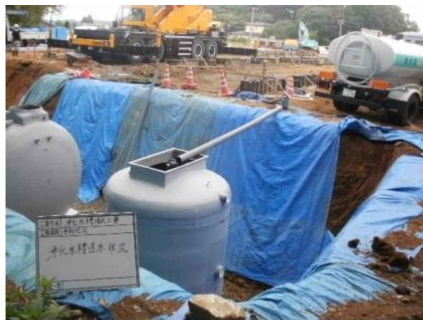
浄化槽埋作業 2
